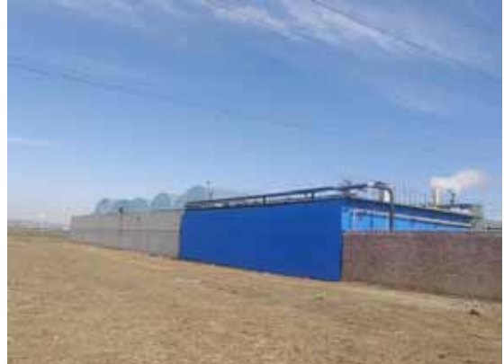
现有工程污水处理设施
