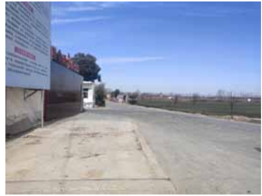
厂区东侧生产路
