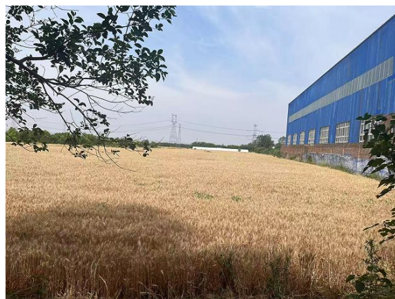
厂区南侧现状
